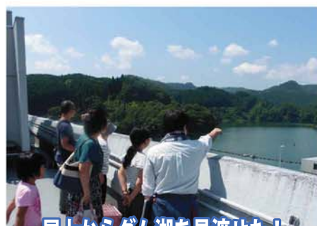
屋上からダム湖を見渡せた！
